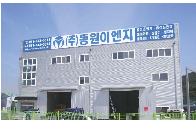
▲ (주)동원이엔지 판탄생산 공장
