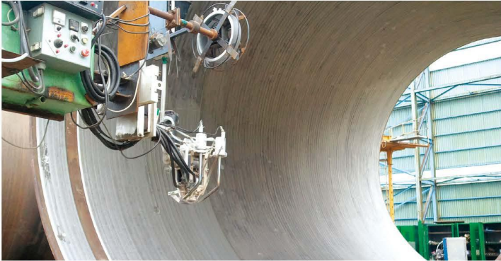
• 디엠티대명이 자체 개발한 육성 용접 자동화 기기
